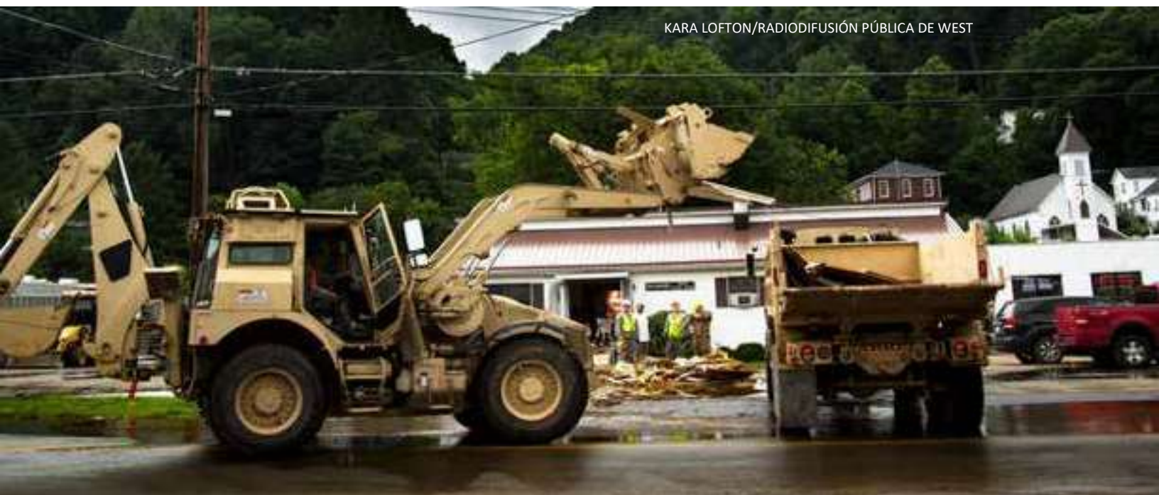
Imagen 23: Despeje del daño por inundación en Richwood.
