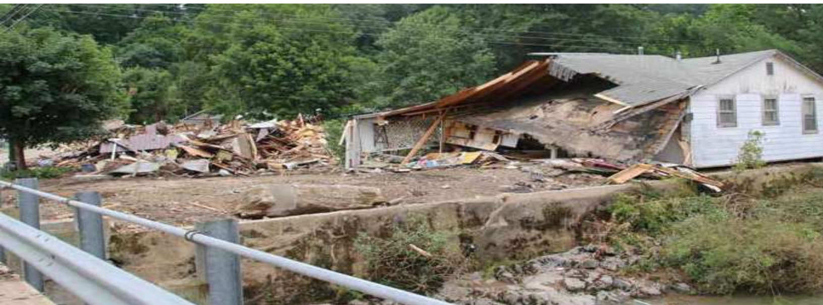
Imagen 21: Vivienda destruida a causa de la inundación
