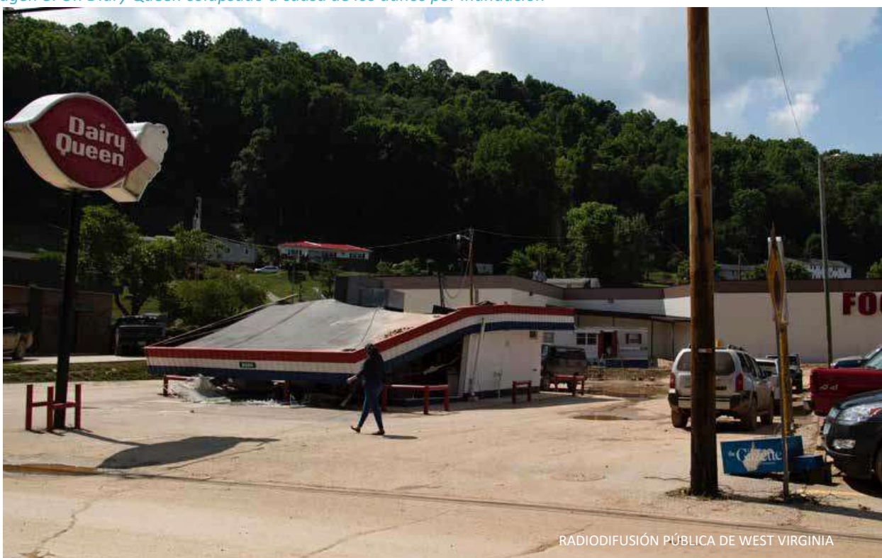
Imagen 8: Un Dairy Queen colapsado a causa de los daños por inundación
